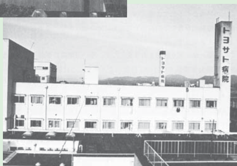
1971年(昭和46) 診療部門を含む 病棟鉄筋コンクリート3階建改築工事
